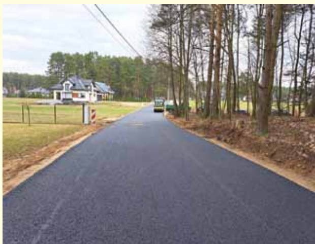
Przebudowa drogi (ul. Bojowników) w Bogusze
