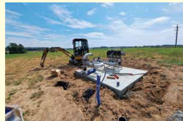
Budowa wodociągu w Gutach Rożyńskich
