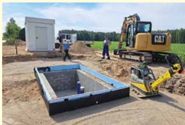
Budowa wodociągu w Żelazkach
