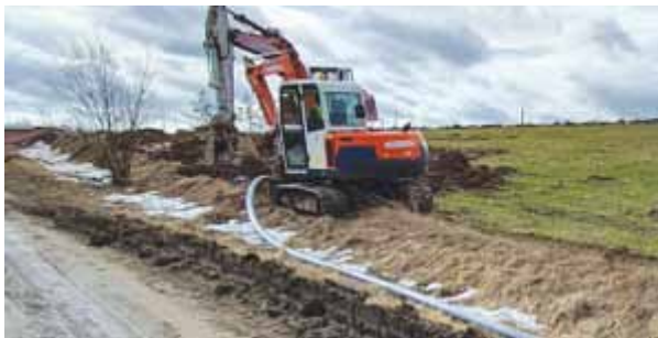
Budowa wodociągu Orzechowo
