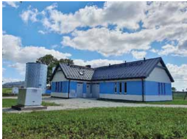
Stacja uzdatniania wody w miejscowości Grabnik
