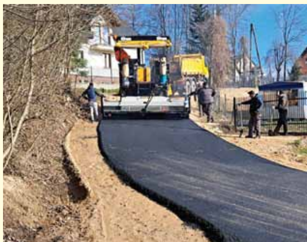
Przebudowa drogi w miejscowości Kurzątki
