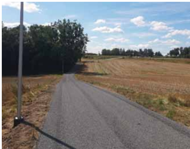
Zmodernizowana droga gminna w Rudzienicach
