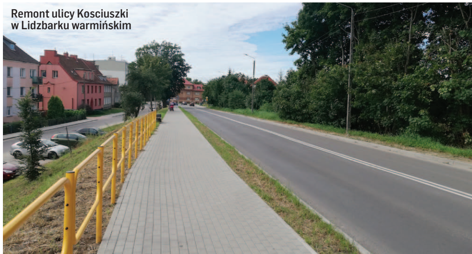
„Remont drogi powiatowej Nr 1535N Lidzbark Warmiński- Jeziorany od km 0+000 do km 14+233”
