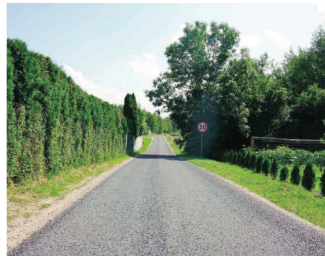
Zmodernizowana droga gminna w Kałdunach
