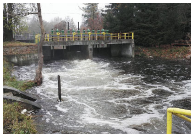
Poziom wody w Jezioraku regulowany jest m.in. poprzez jaz wodny na Iławce
