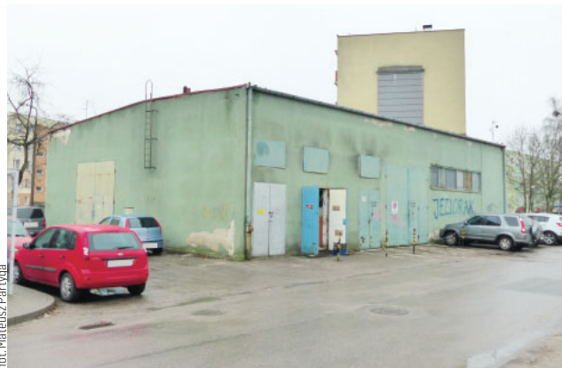
Tak obecnie wygląda „wymiennikownia” przy ul. Okulickiego na os. Podleśnym w Ławie
