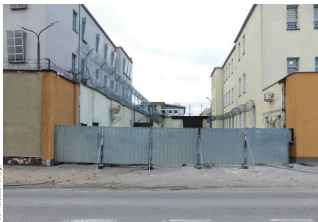
Nowa brama ma zostać zamontowana do 20 grudnia 2021
