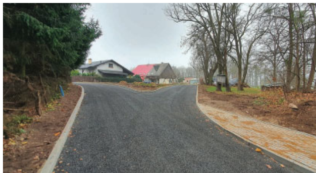
Przebudowana droga gminna w Szczepkowie
