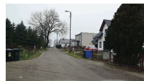
Zaplanowane są także budowy ulic: Dobrawy, Łąkowej, Działdowskiej, Podleśnej za kwotę 970 tys zł oraz ulicy Stalowej od ronda na ulicy Piaskowej do terenów inwestycyjnych za 1 505 070 zł
