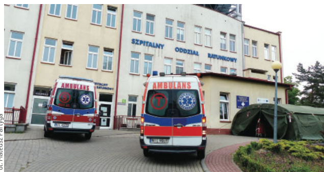
Szpital powiatowy w Iławie — wejście do SOR
