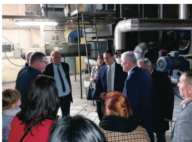
– Wizyta w ciepłowni miejskiej
