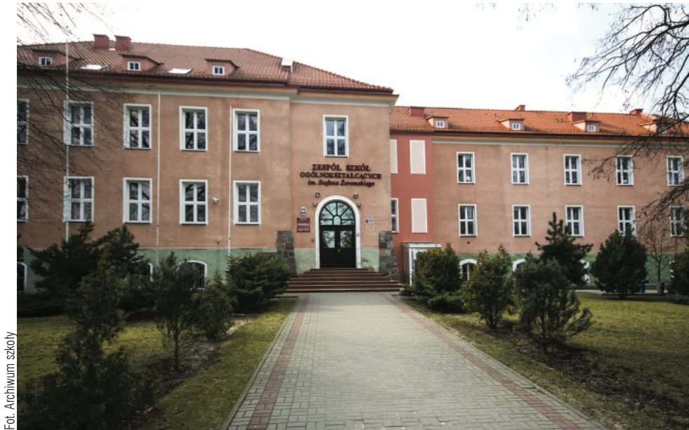
Budynek Zespołu Szkół Ogólnokształcących im. S. Żeromskiego w Ławie
