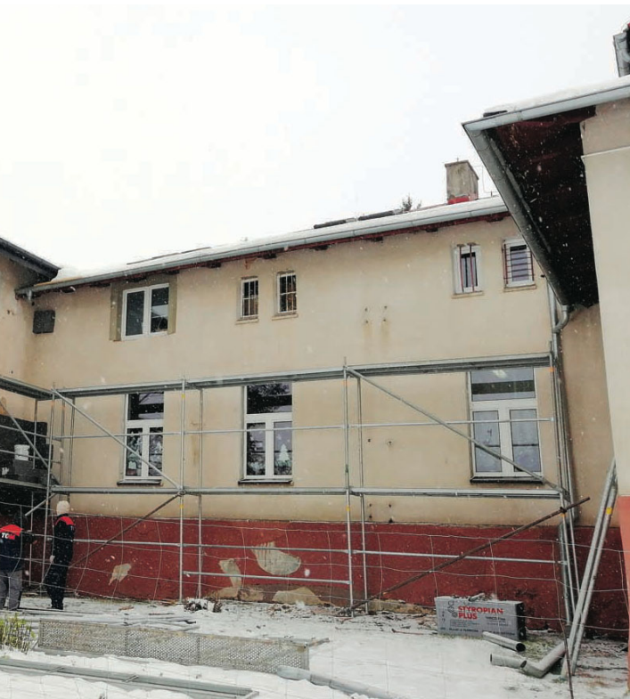
Remontowana Szkoła Podstawowa w Lasecznie
