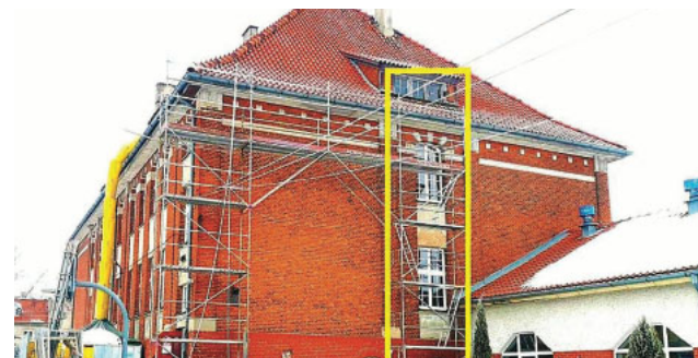
Winda będzie w miejscu okien
