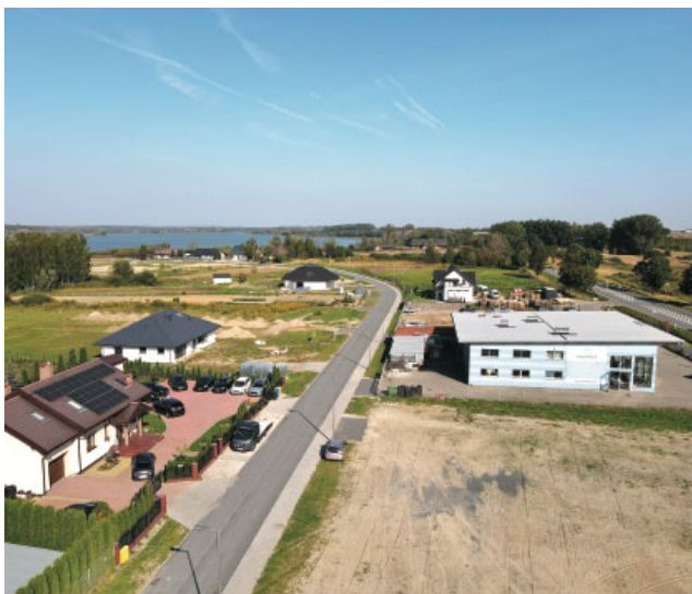
Przebudowana droga gminna ul. Księżycowa w Nowej Wsi
