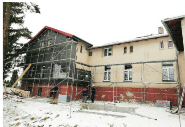
Przebudowywana Szkoła Podstawowa w Lasecznie
