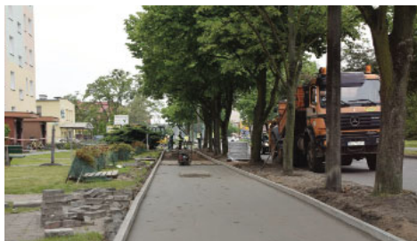
Remont chodnika przy ul. F. Smolki
