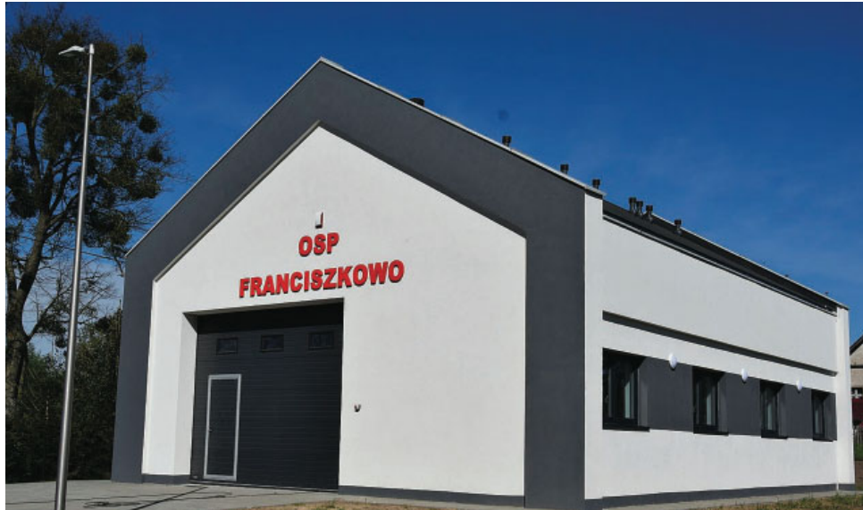
Nowowytbudowana remiza OSP we Franciszkowie
