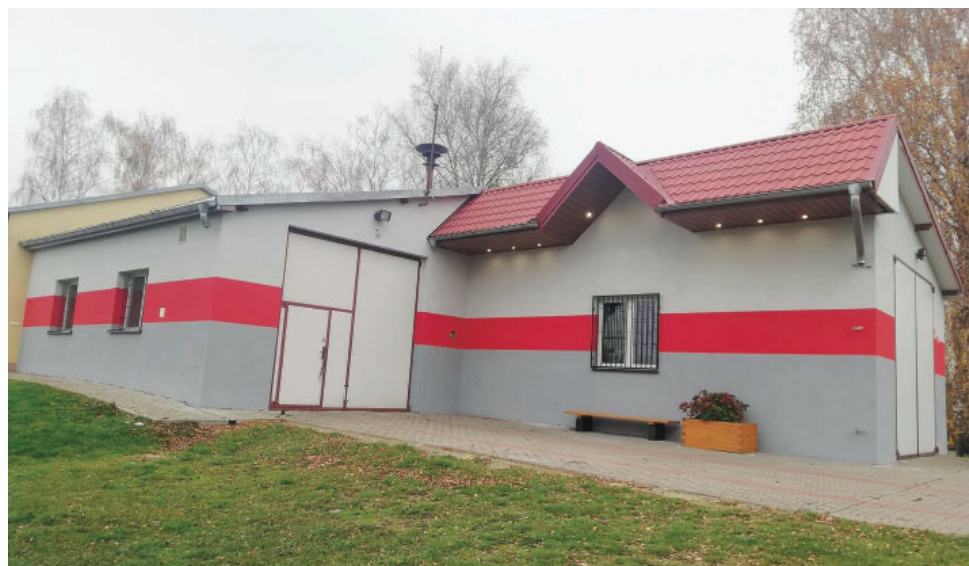
Odnowiona elewacja remizy OSP Ławice
