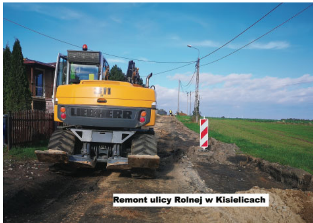
Remont ulicy Rolnej w Kisielicach
