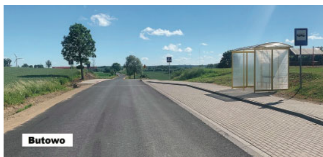
Droga w kierunku Sobiewoli – widok od DK nr 16
