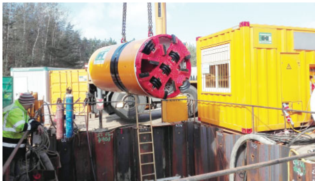
Pograżenie głowicy drążącej kanał pod kolektor deszczowy
