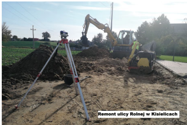
Remont ulicy Rolnej w Kisielicach
