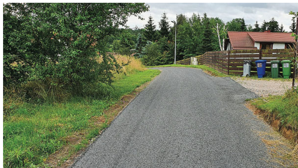
Wyremontowana droga w Dziarnówku
