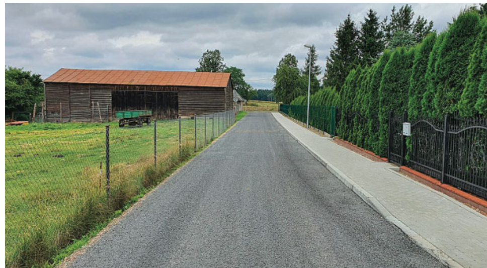
Wyremontowana droga we Frednowach
