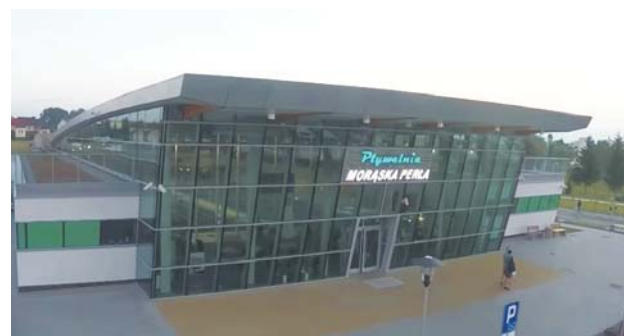
Pływalnia „Morąska Perła”
