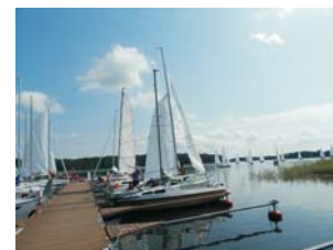
Zmodernizowana przystań żeglarska w Bogaczewie
