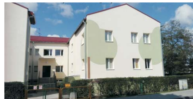
Termomodernizacja budynków Przedszkoli
