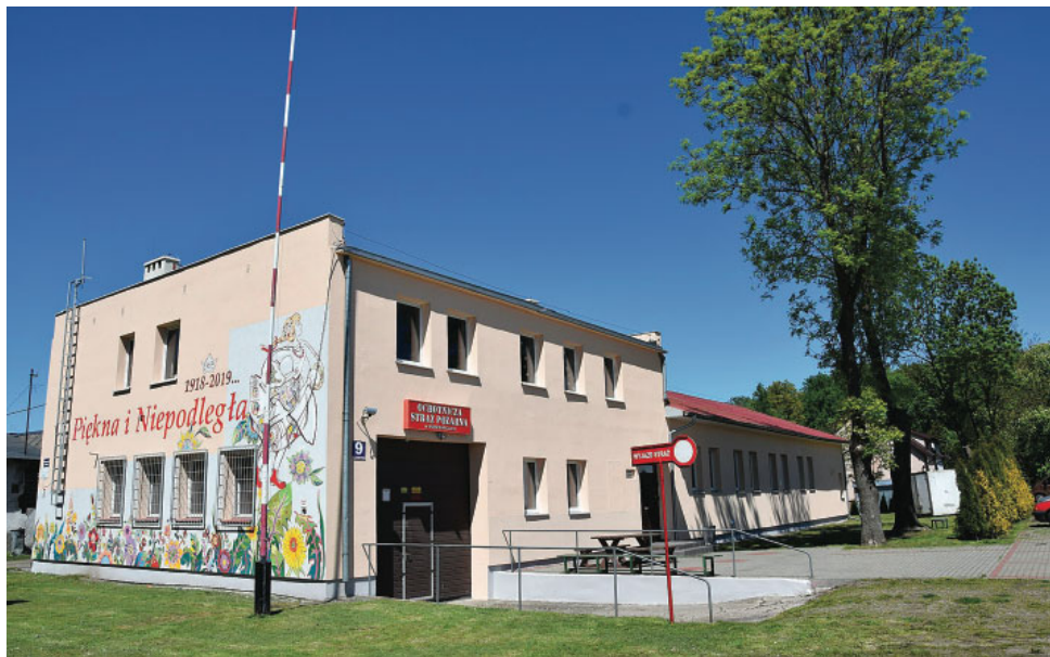
Wyremontowana świetlica w Rudzienicach
