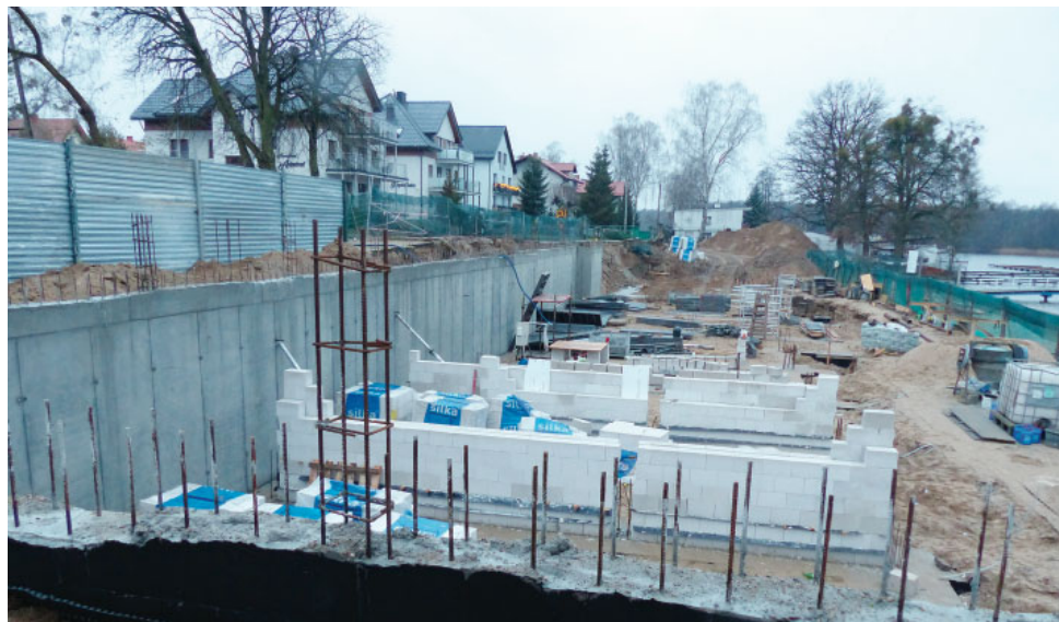
W końcu pierwsza łopata została wbita, niedawno na placu budowy nowego hotelu „Kormoran” pojawiły się palety z ceglami. Mury pną się do góry
