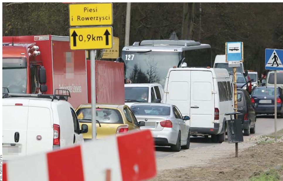
Na ul. Zientary-Malewskiej trwają roboty drogowe. Wprowadzono tu sygnalizację świetlną, a ruch odbywa się wahadłowo. W obu kierunkach tworzą się duże korki
