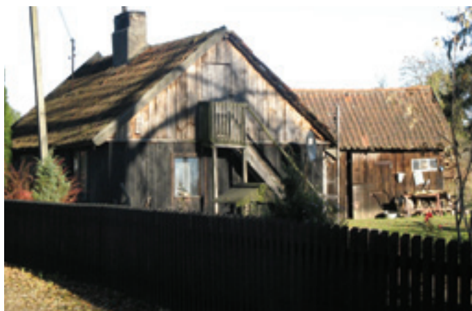
Drewniane chałupy na Mazurach często są w fatalnym stanie, wymagają gruntownej renowacji i fachowego oka Fot. Anna Banaszkiewicz
