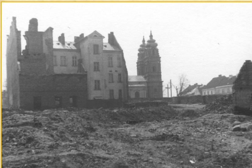
Zniszczone budynki południowej pierzei rynku i dawnej ulicy Działdowskiej (II wojna światowa)
