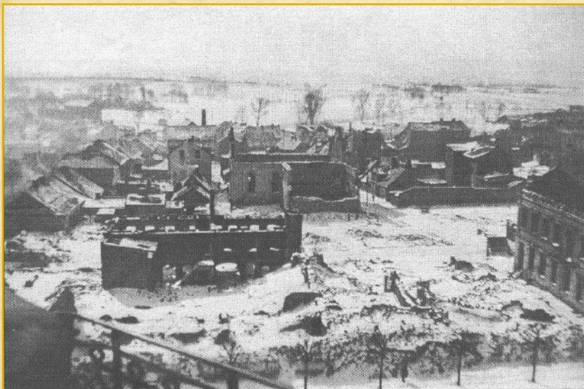
Widok zniszczonych budynków południowej pierzei mławskiego rynku (II wojna światowa)
