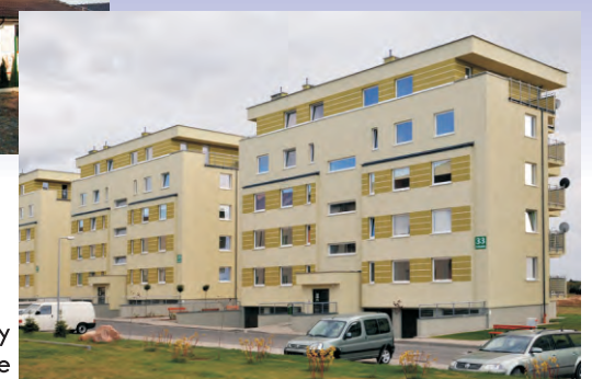
Budynek wielorodzinny w Mławie
