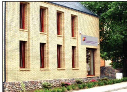
Nowa siedziba Funduszu przy ul. Wolności w Działdowie.
