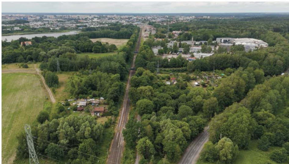
Mieszkańcy Zatorza poprzez tunel pod torami zyskają nowe połączenie z resztą miasta. Nowy trakt będzie wieść od ul. Zientary-Malewskiej do węzła Wschód południowej obwodnicy Olsztyna.
