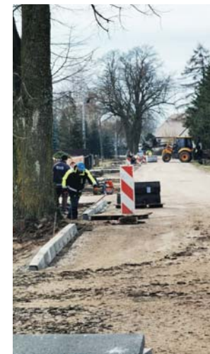
Przebudowa chodnika – Wielki Łęck
