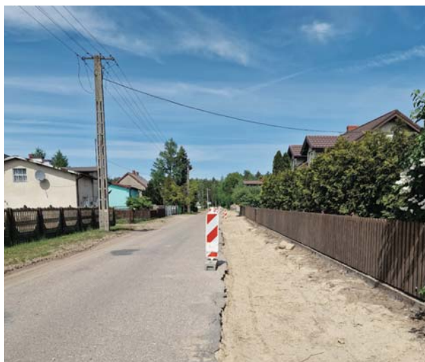
Przebudowa chodnika w miejscowości Bryńsk
