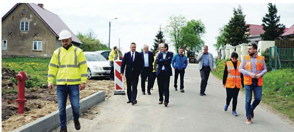
Z roboczą wizytą na inwestycjach drogowych
