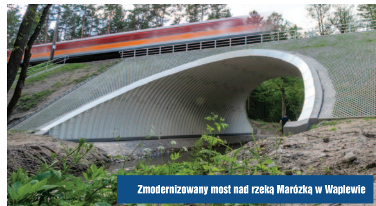
Wszystkie przebudowane stacje na trasie Szczytno - Pisz - Ełk zapewniają podróżnym oczekiwany standard obsługi
