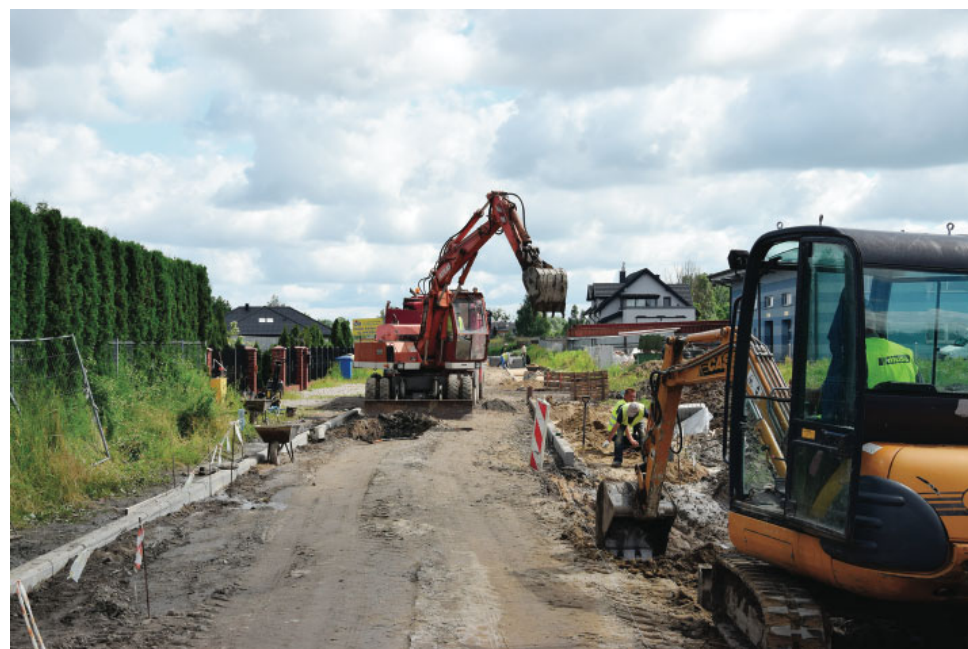
Przebudowywana ul. Księżycowa w Nowej Wsi
