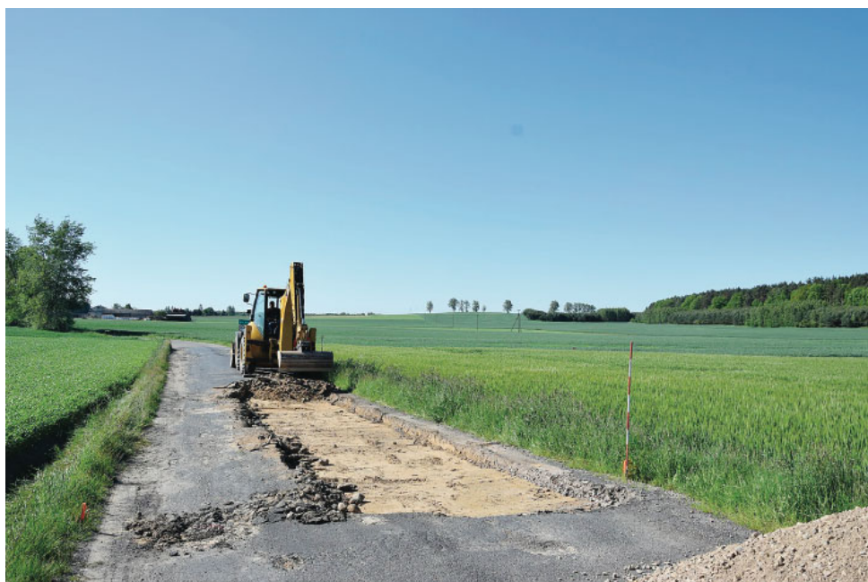
Przebudowywana droga Gulb-Wólka
