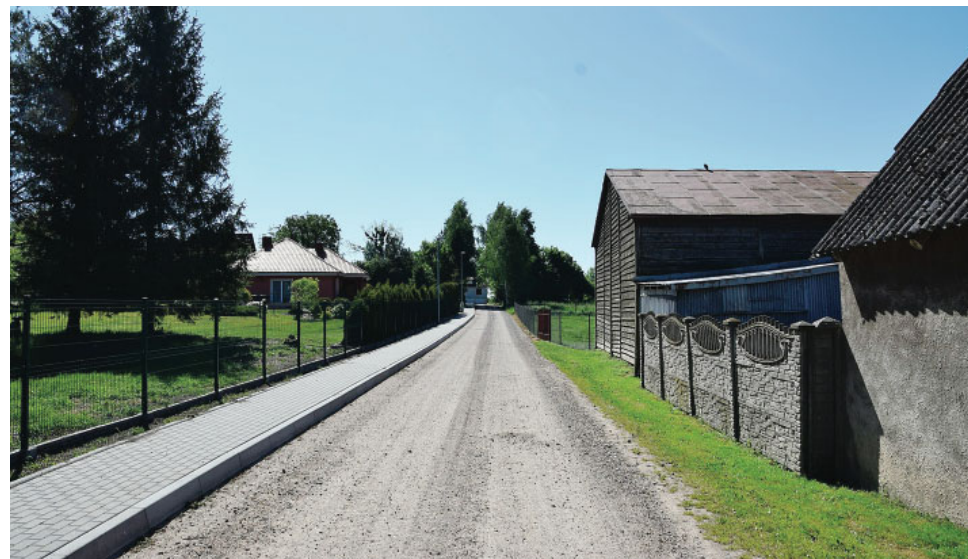
Przebudowywana droga we Frednowach
