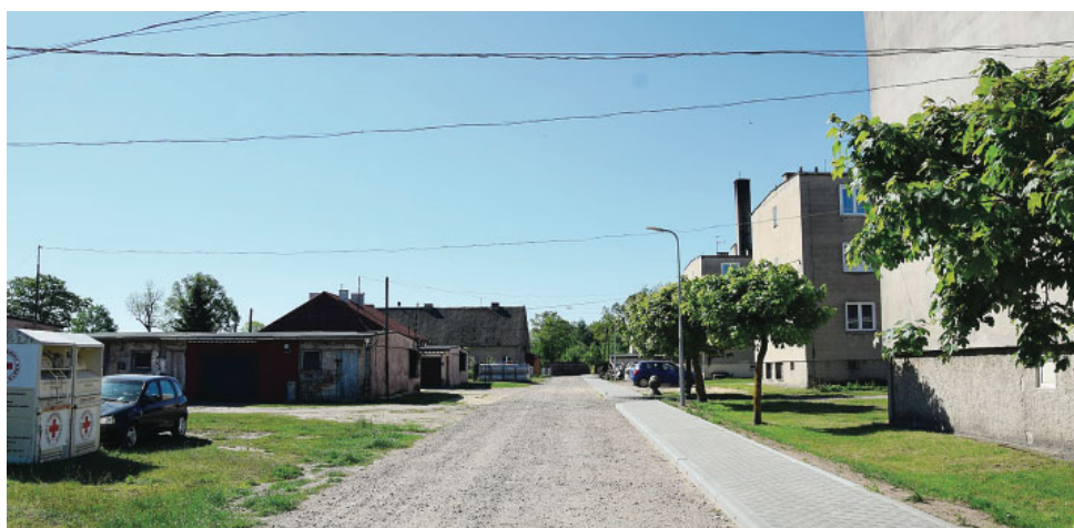
Przebudowywana droga w Szymbarku
