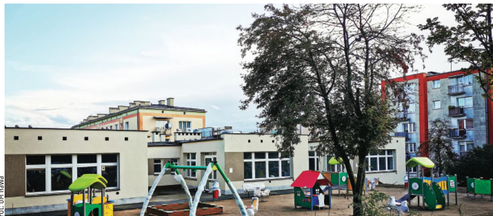
Prace w budynku przy ul. Obrońców Westerplatte, w którym niegdyś mieściło się przedszkole miejskie a także MOPS-ik, są już na ostatniej prostej. Niedługo zostanie tu otwarty żłobek
