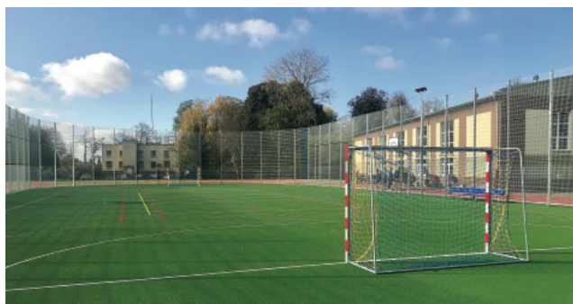
Zmodernizowane wielofunkcyjne boisko z pewnością uatrakcyjni sportowe zaplecze lubawskiej szkoły
