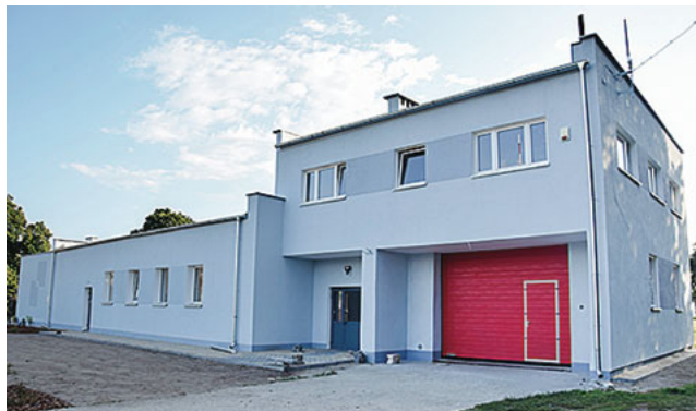
Wyremontowana świetlica w Maćkach
