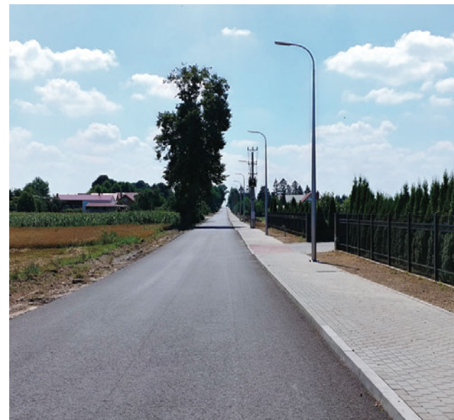
Przebudowana ul. Lipowa w Rudzienicach.
