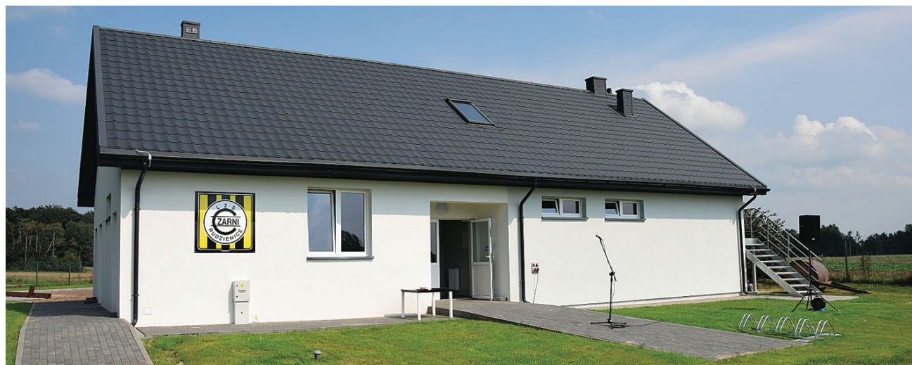
Na zdjęciu nowy budynek klubowy Czarnych Rudzienice.
