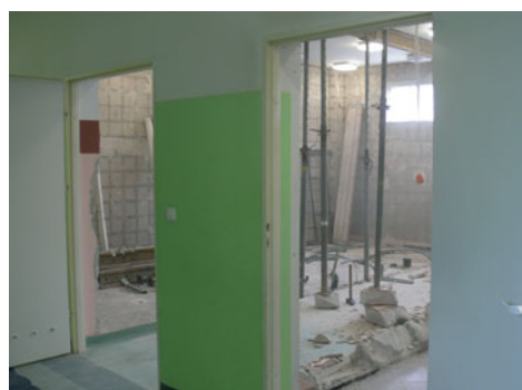
Adaptacja pomieszczeń na przedszkole w SP nr 1
