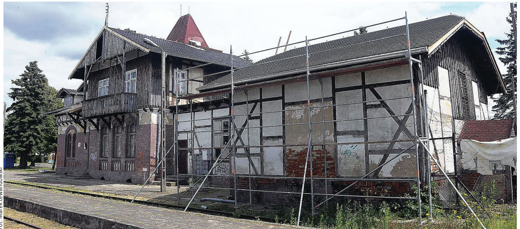
Trwa remont dworca w Tolkmicku. W pierwszym etapie prac skoncentrowano się na remoncie dachu
