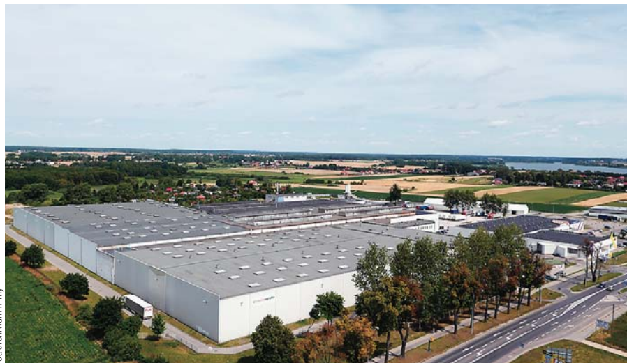
W Iławie trwa rozbudowa Centrum Logistycznego Logistic Szynka, którego docelowa, łączna powierzchnia magazynowa wyniesie ponad 57 000 m 2
