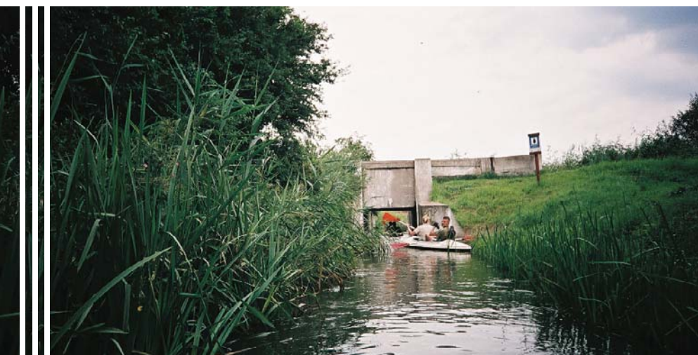
Kanał Kiermas krzyżuje się z Kanałem Elżbiety, który przepływa ponad nim w betonowym korycie
