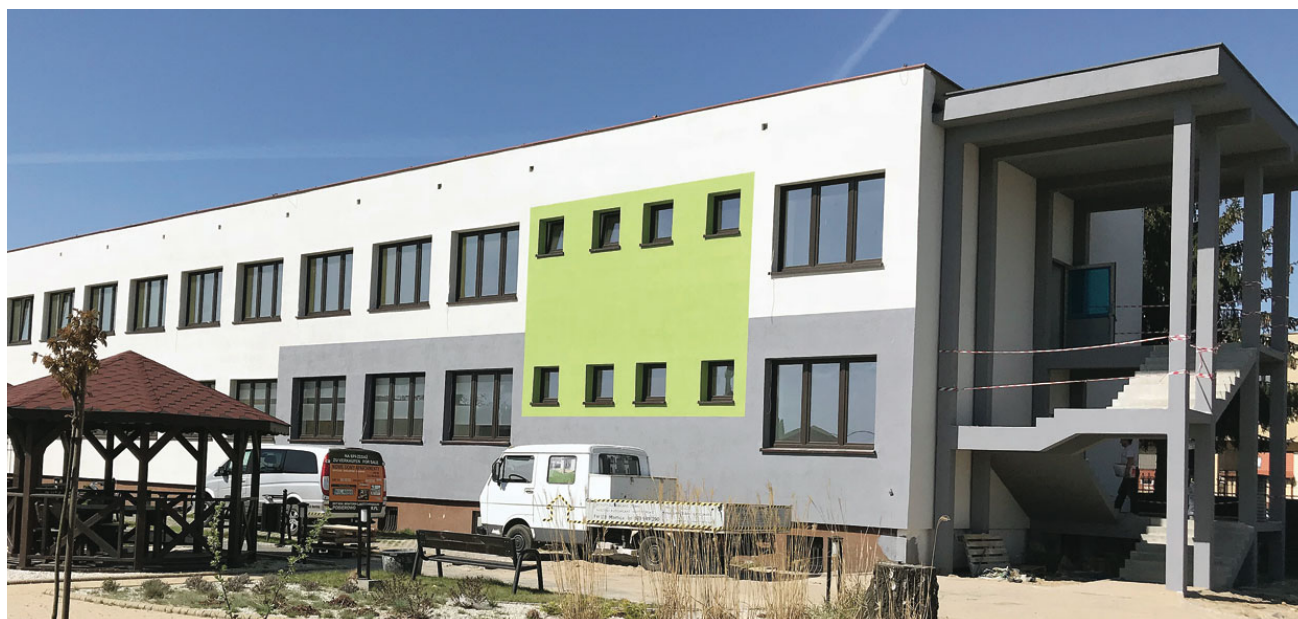
Pawilon psychiatryczny zyskał nową elewację oraz schody pozwalające wyjść pacjentom na teren rekreacyjny
