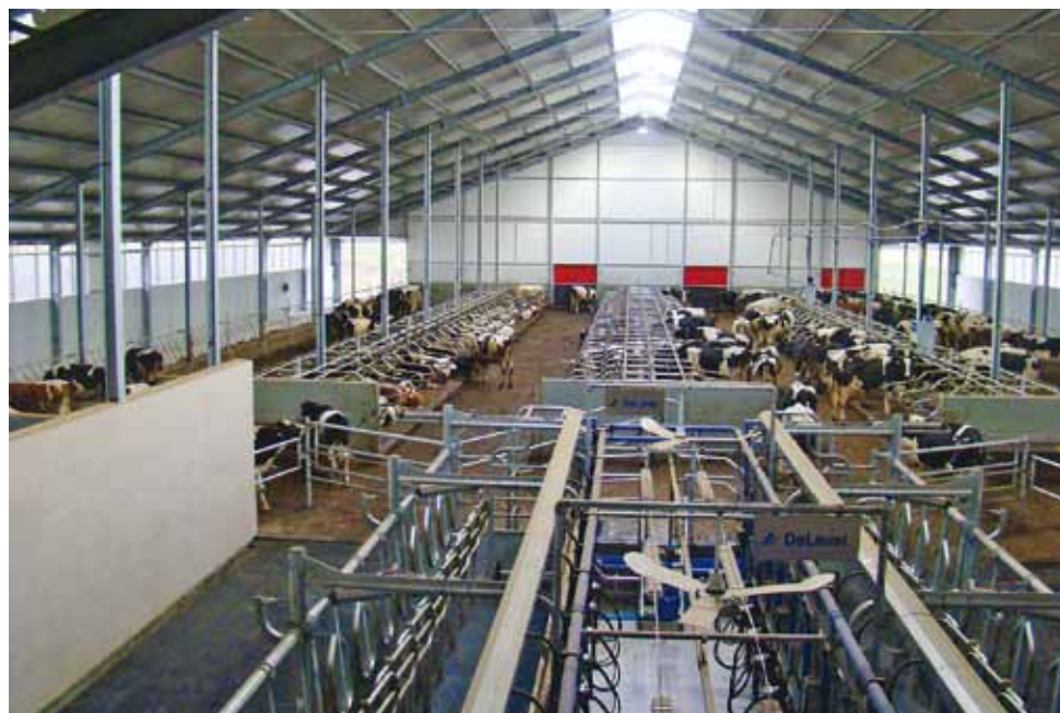
Wymiary obory to 67 m x 38 m. Przewidziana jest na 180 stanowisk, plus izolatki oraz dojarnia typu „bok w bok” na 24 stanowiska udojowe Fot. Monika Kopacz-Radziulewicz
