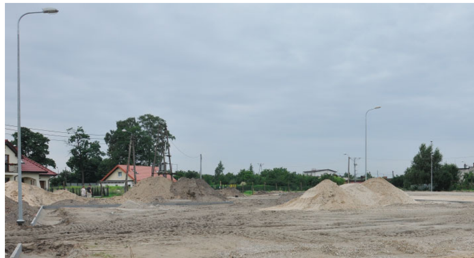
Przy ulicy Polnej powstaną trzy boiska i parking Fot. Urząd Miejski w Suszu
