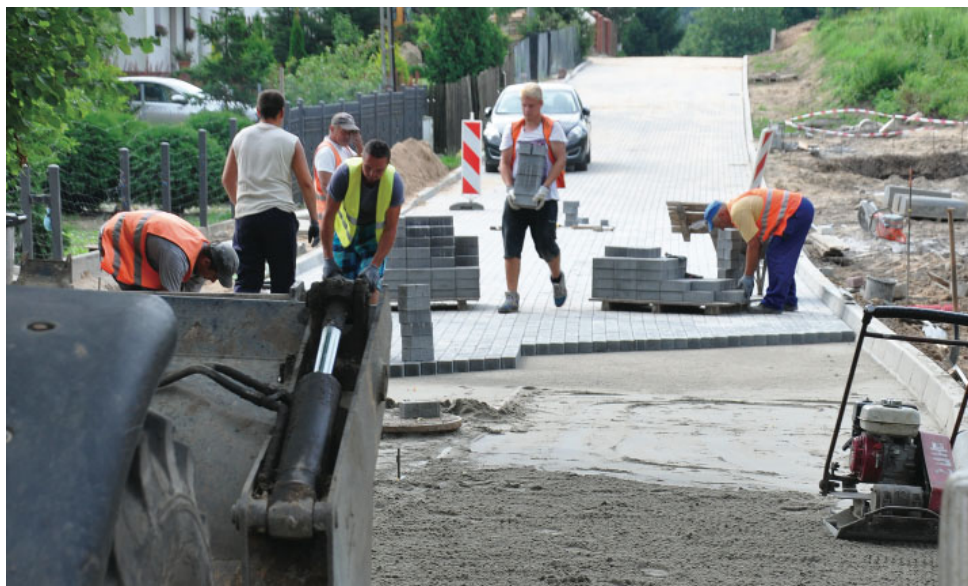
Prace na ul. Rybackiej zakończono kilka dni temu
