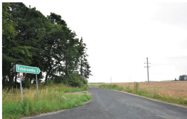
Przebudowana droga gminna Ławice - Tchorzanka
