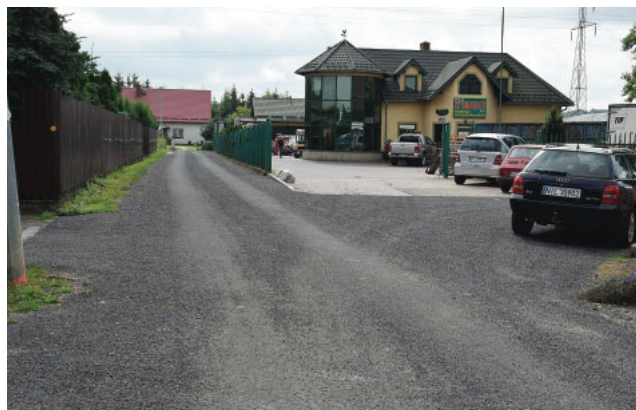
Przebudowana droga gminna w Wikielcu
