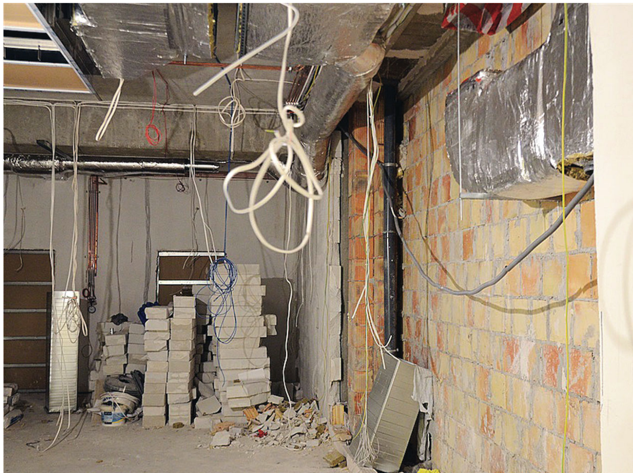
Pomieszczenie, w którym będzie zlokalizowana sala cięć cesarskich Fot. Arch. szpitala
