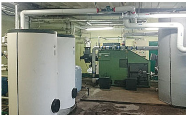
Wymiana kotła węglowego na kocioł na biomasę
