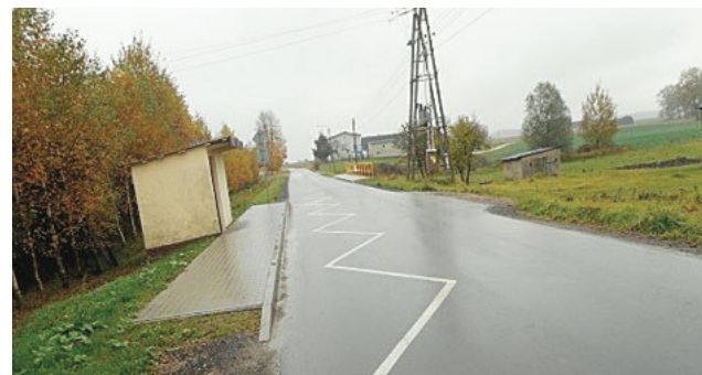
Jeden z wyremontowanych odcinków dróg powiatowych, w gminie Susz
