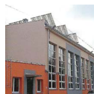
Kolektory słoneczne na dachu ZS im. I. Kosmowskiej w Suszu
