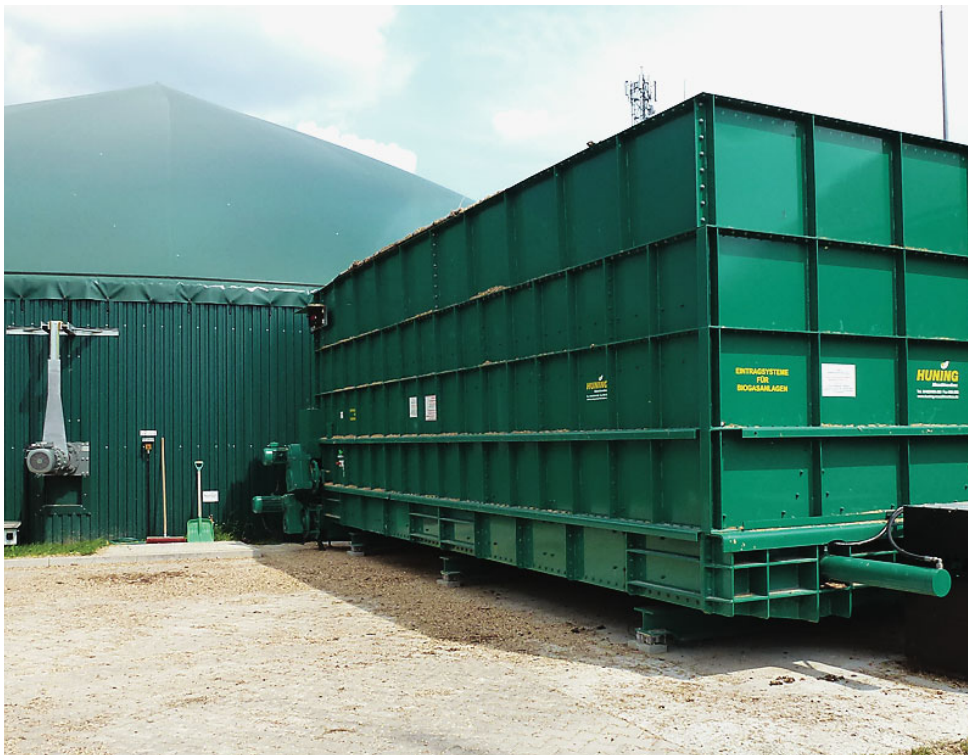
Kontener załadowniczy substratu do komory fermentacyjnej w biogazowni w Rybołach koło Białegostoku Fot. Eugeniusz Mystkowski
