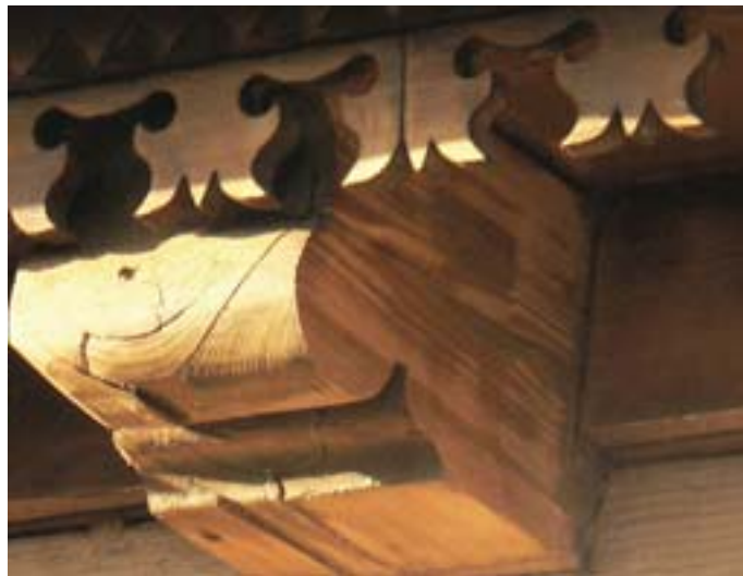
Dekoracje pod okapem dachu przykrywającego wystającą końcówkę belki stropowej (kroksztyn) Fot. Filip Gawliński
