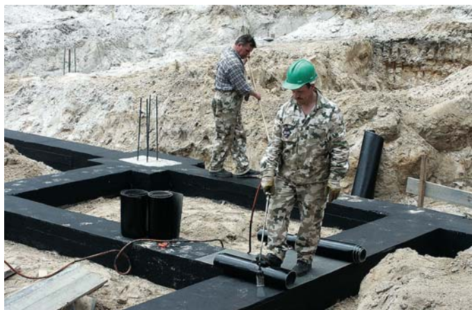
Pomoc finansową w ramach działania „Różnicowanie w kierunku działalności nierolniczej” będzie można otrzymać między innymi na rozwój usług budowlanych. Fot. Atlas
