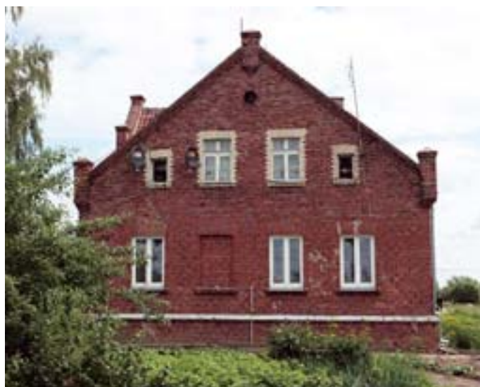
Widok na szczyt domu ceglanoego z początku XX wieku w Kępiewie, gmina Markusy – przykład trwałości dawnej cegły Fot. Filip Gawliński
