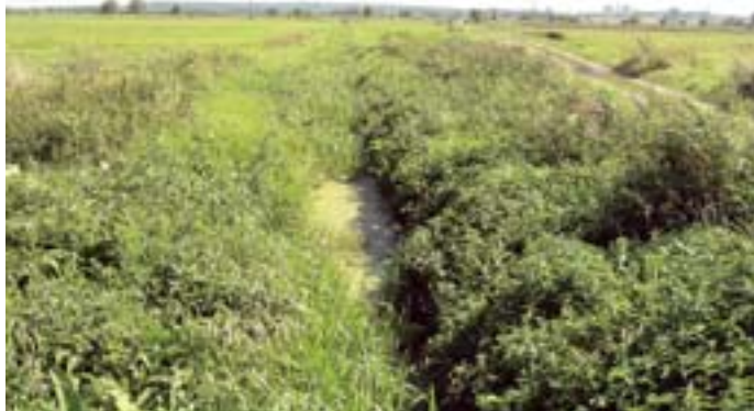
Zarośnięty roślinnością row melioracyjny nie spełnia funkcji odwadniająco-nawadniającej
