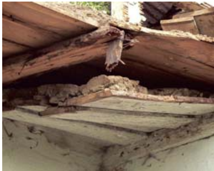
Podsufitka między piętrzem a poddaszem kryjąca docieplającą polepę glinianą. Ciekawe rozwiązanie deskowania sufitu – naprzemienne. Dom podcieniowy w Świętym Gaju Fot. Filip Gawliński
