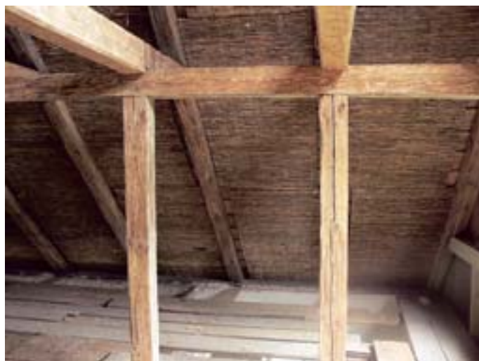
Rozwiązanie ocieplenia dachu tradycyjnymi metodami – współcześnie montowane maty trzcinowe w XIX wiecznym drewnianym zabytku Fot. Filip Gawliński
