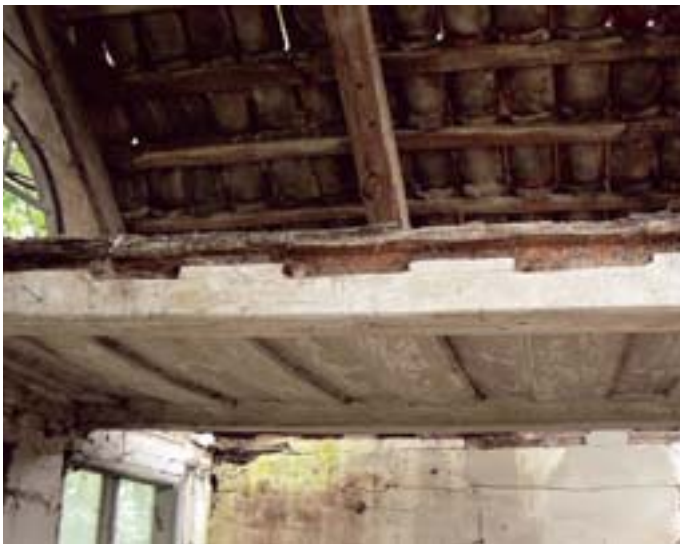
Podsufitka między piętrzem a poddaszem kryjąca docieplającą polepę glinianą. Ciekawe rozwiązanie deskowania sufitu – naprzemienne. Dom podcieniowy w Świętym Gaju Fot. Filip Gawliński
