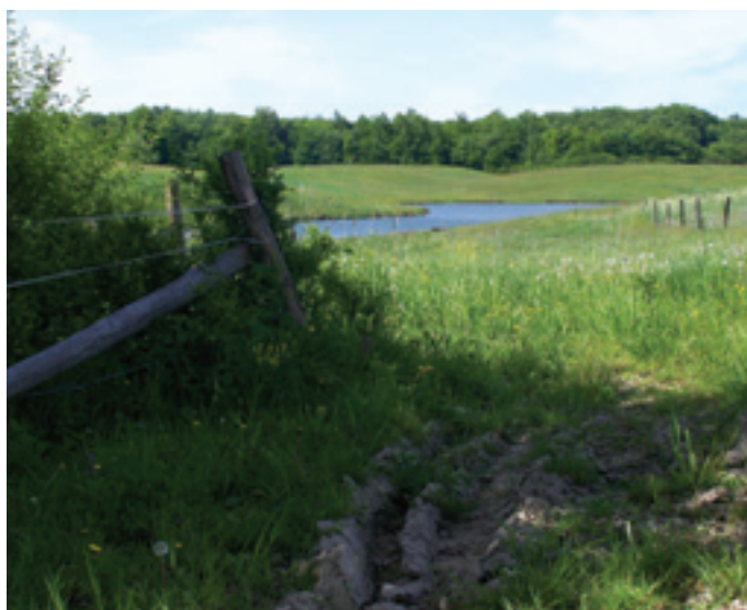
Zniszczona droga gruntowa
