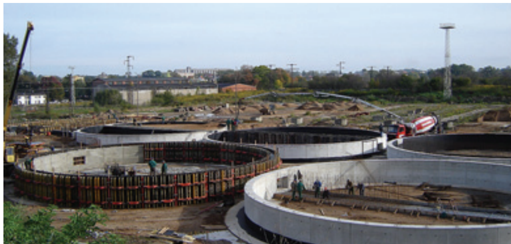
Zakład, który powstaje w Kętrzynie, będzie należał do nowej generacji, a swoim zasięgiem i potrzebami surowcowymi na pewno wyjdzie poza granice okolicznych powiatów Fot. Eco-Brasco
