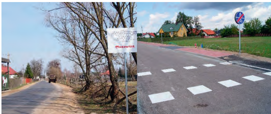
Droga gminna przed ... i po przebudowie (Gmina Olszewo-Borki, powiat ostrołęcki). Archiwum UG Olszewo-Borki
