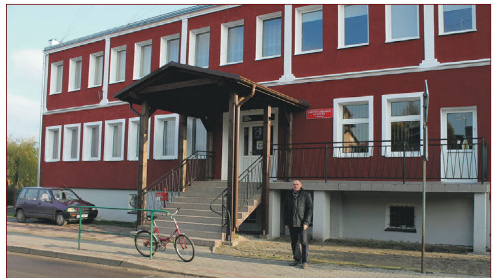
Wójt gminy Płońska Krzysztof Groblewski na tle nowo wyremontowanego budynku GOK. Fot. archiwum
