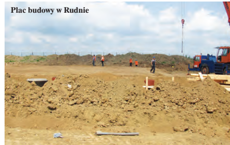
Plac budowy w Rudnie
