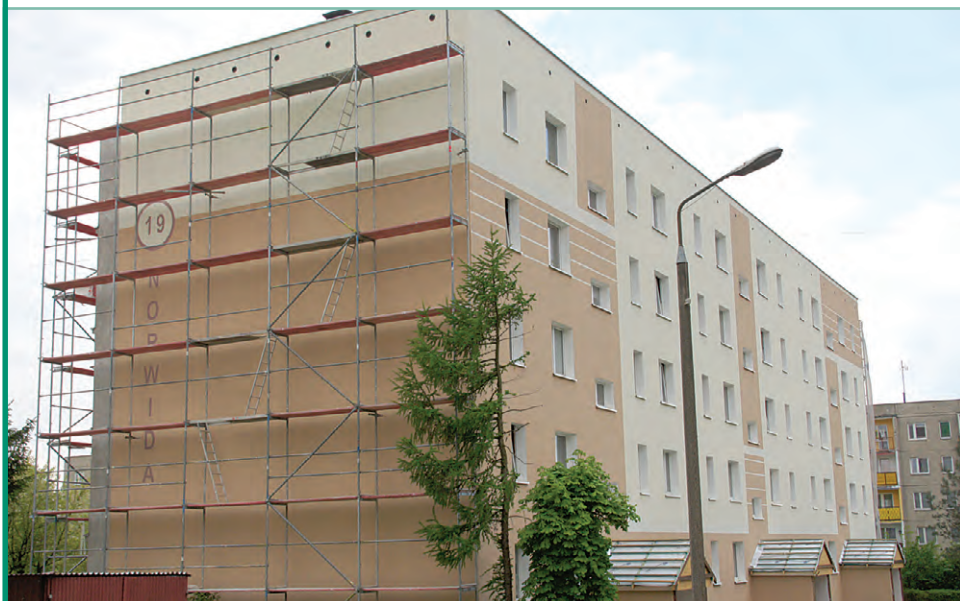
Przy ul. Norwida docieplane są bloki. Na zdjęciu budynek przy ul. Norwida 19
